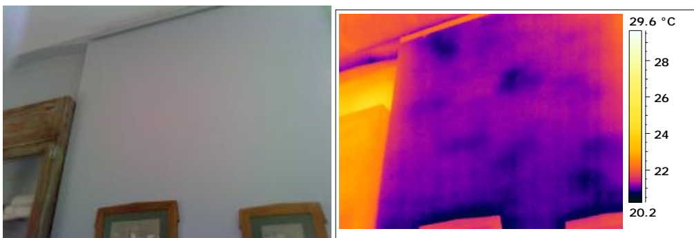
Slika 3. Digitalni snimak i termogram zida u hodniku, deo prema ulici sa vidljivim hladnijim zonama Figure 3. Digital photo and thermogram of the outer wall facing the street, cold zones are visible
