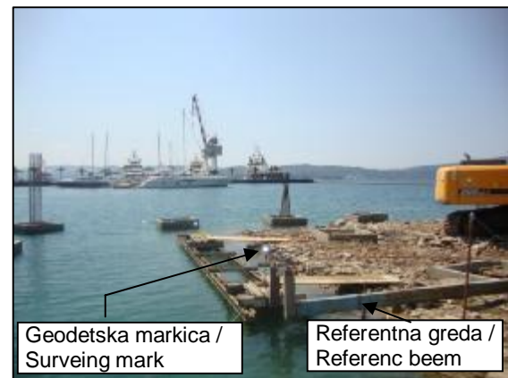
Slika 7. Fotografije ispitivanja šipova na doku 4 Figure 7. Photos of tests on piles supporting Jetty 4
